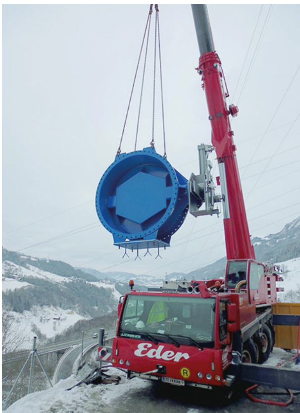
Bild 1: Stahlgeschweißte VAG EKN® Absperrklappe DN 2400 wird zu ihrem Bestimmungsort transportiert.
