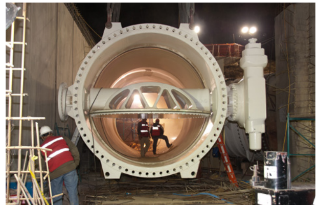
Bild 2: Eine VAG EKN® Absperrklappe mit einem Nenndurchmesser von 3,5 Metern
